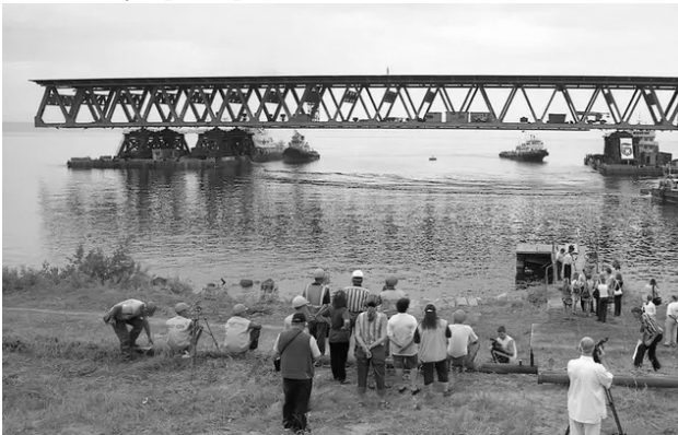
Строительство Президентского моста через р.Волга
